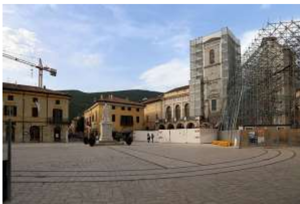
Foto 9. Basilica di San Benedetto del siglo XII, en Norcia (Italy) en proceso de restauración tras el terremoto de magnitud 6,5 de 2016.
