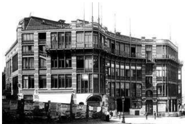
Fotografija 2. Nekdanja hiša ljudstva (Maison du people) v Bruslju (Belgija), ki jo je zasnoval Victor Horta (1896-1898) in so jo mestne oblasti kljub protestom številnih arhitektov in mednarodnega odbora Beneške listine leta 1965 porušile zaradi urbanističnega razvoja (na njenem mestu je bil zgrajen nebotičnik).
